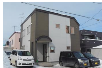
3月例会でテーマとなった小規模多機能型住宅介護「春の歌」の外観
